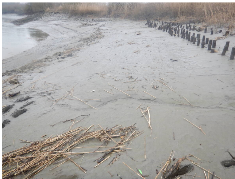
Figuur 12.40: NTMB-oever (natuurtechnische milieubouw), verstevigd met palenrijen aan de Kramp.
